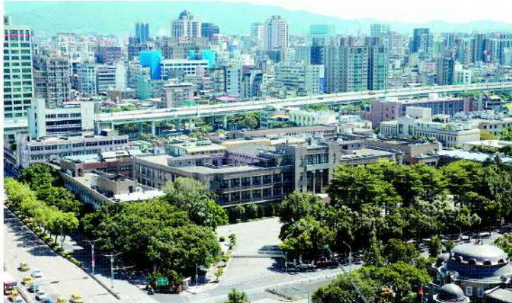
廿年來重要公共建築的耐震補強慢如牛步，身為最高行政機關行政院的補強率竟然掛零。記者邱德祥／攝影
